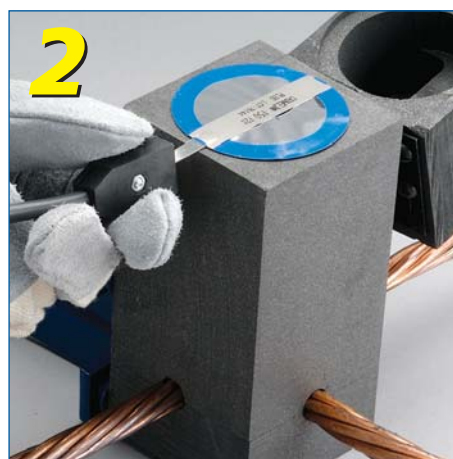
Conecte o cabo da Unidade de Controle ao terminal de contato do cone de aço
